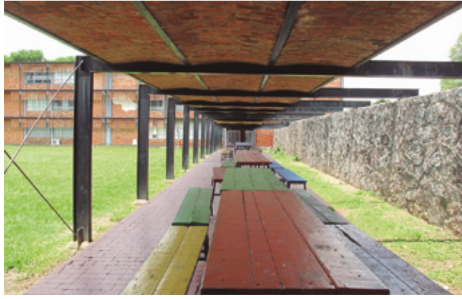
Figura 8 Pasarela de conexión entre edificio principal y Escuela Anexa, Centro Regional de Ciudad Guzmán. Fuente: Fotografía de las autoras.
