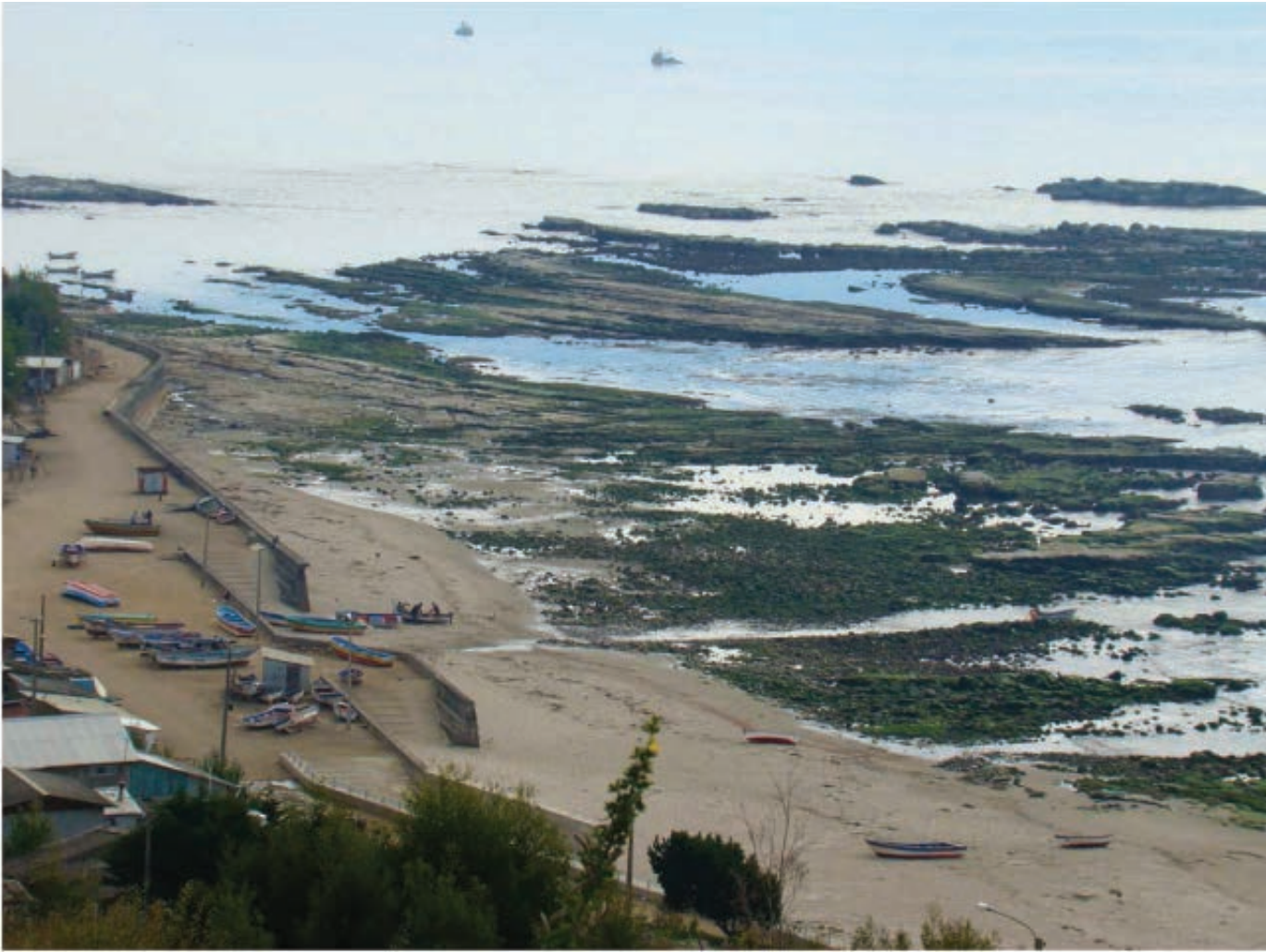
Figura 8 Levantamiento continental frente a la playa de arena de Punta Lavapie. El sustrato rocoso que ahora ocurre expuesto al aire durante marea baja, estaba siempre sumergido antes del terremoto del 27 de Febrero del año 2010. El levantamiento de ese sustrato, ha eliminado del nivel inferior de la playa de arena la zona de rompiente de las olas, el hábitat típico del “chanchito de mar” Emerita analoga (ver texto). Foto: Eduardo Jaramillo.
