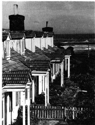
Viviendas para empleados. Maule. Foto arquitecto Rodrigo Fischer P.
