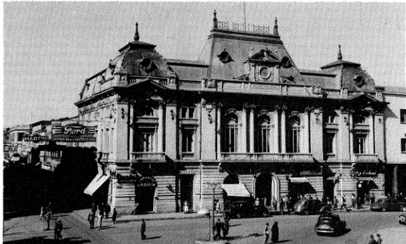
Fig. 18. Antiguo Edificio de la Municipalidad de Concepción.
