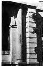
Fig. 110. Detalle columna vivienda calle Angol.
