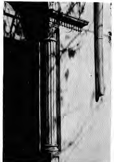
Fig. 93. Detalle columna en acceso, Galvarino 547.
