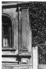
Fig. 114. Detalle columna, Chacabuco 1142.
