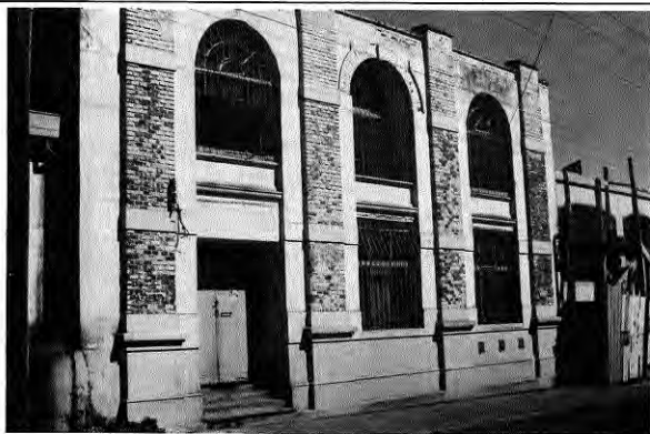
Fig. 84. Edificio calle Ongolmo 551, Concepción.
