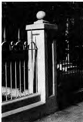
Fig. 145. Columna plinto con bola de cemento.
