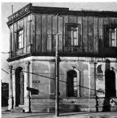
Fig. 49. "Casa de la columna de lata". Angol esquina Cochrane.
