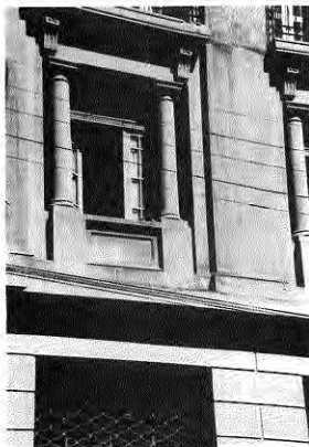
Fig. 81. Detalle de columnas en ventana 2º piso.
