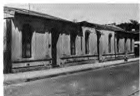
Fig. 86. Conjunto viviendas 1 nivel. Ormpello 80, Concepción.
