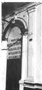
Fig. 105. Detalle acceso y columna, Maipú 1108.
