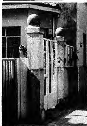
Fig. 146. Columna plinto con bola de cemento.
