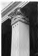
Fig. 48. Columna en el 1º piso.
