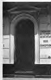
Fig. 100. Detalle acceso vivienda en calle Barros Arana.
