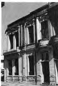
Fig. 69. Tímpanos de remate curvo sobre ventanas del 2º piso.
