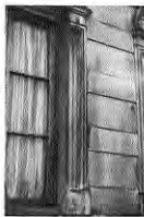
Fig. 95. Detalle acceso San Martín 327.
