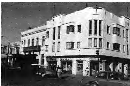
Edificio de equina en hormón armado. Corresponde a las primeras tipologías modernas surgidas en Punta Arenas.
