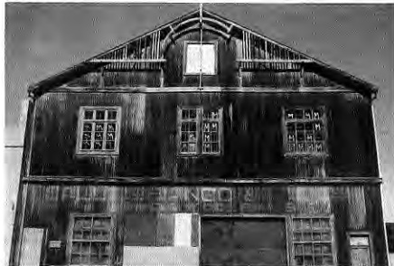
Vemos un ejemplo de la arquitectura utilitaria en estilo traédico. Estructura de madera reversida exteriormente en latón. Este edificio corresponde a una gran bodega.
