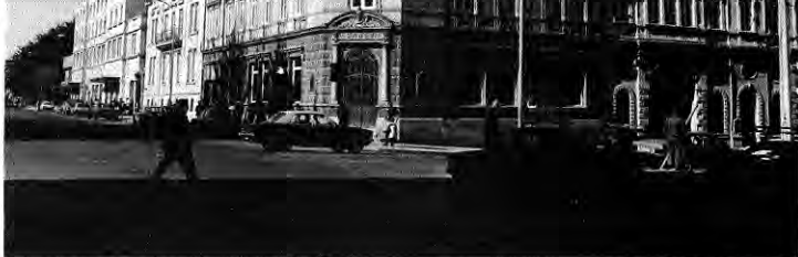
Edificio neoclásico en el centro de Punta Arenas. La esquina se ve magnificada por el acceso, las columnas y los frontones. El techo anaranjado está recubierto en fierro galvanizado estamapado.
