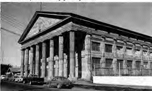
Palacio del depósito de estilo clásico griego en hornigón armado.
