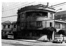
Edificio de vivienda en 3 pisos con balcón superior en astrágalo. Calle O'Higgins esquina Serrano, Concepción.
