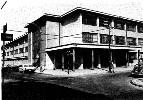
Edificio Liceo Comercial en Calle Caspolián esquina Cochrane, Concepción.
