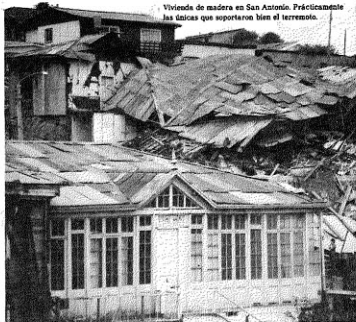
Vivienda de madera en San Antonio. Prácticamente las únicas que soportaron bien el terremoto.
