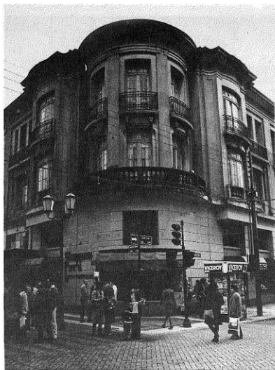
Palacio Hirmas en su actual estado.
