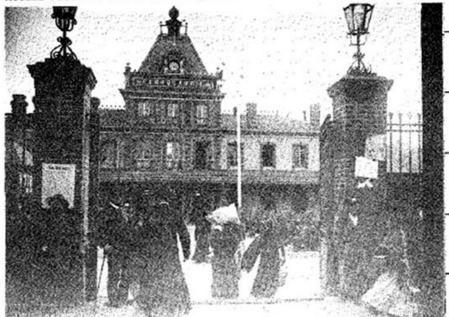
Antigua Estación de Ferrocarriles
