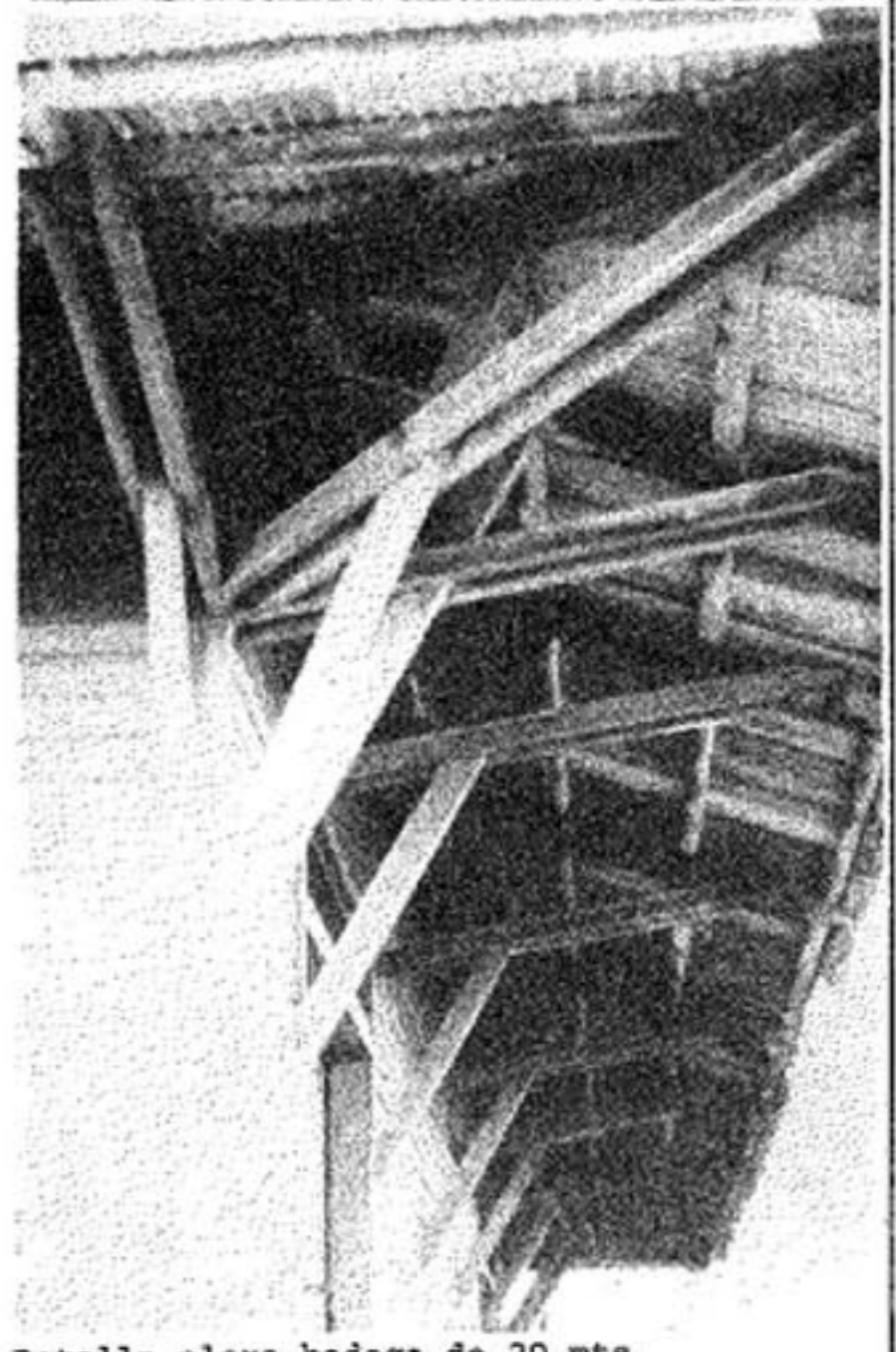
Detalle alero bodega de 20 mts.
