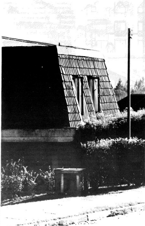
Dos ejemplos de utilización indiscriminada de los materiales: en la foto superior, teja de arcilla empleada como revestimiento de paramentos verticales. Vivienda en Lomas de San Andrés, Concepción.
