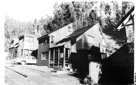
Utilización de nuevas tecnologías en la madera. Conjunto habitacional en Lonco Oriente, Concepción. Arquitectos R. Hempel H. y G. Valverde V.
