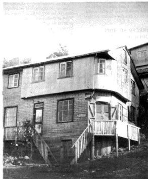
Vivienda en calle Pedro Montt en Castro. Estructura de madera y revestimiento exterior de fierro galvanizado ondulado; madera imitación ladrillo. Esta corresponde a una primera manifestación aún incipiente del "Modernismo nativo" en Chiloé, con elementos de diversas procedencias: palafitos; modernismo en madera y latón; nail.
