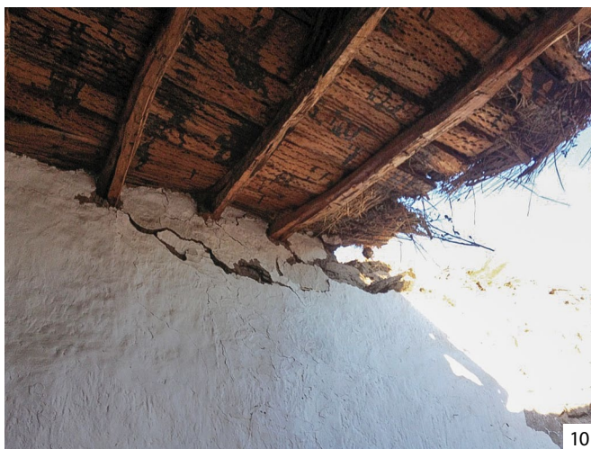
Figura 10 evidencia del empuje de los pares sobre el coronamiento del muro del Evangelio. Fuente S. Alfaro, junio 2014 / Figura 11 desplome en muro del Evangelio, encuentro con cuerpo perpendicular a la nave. Fuente S. Alfaro, marzo 2014
