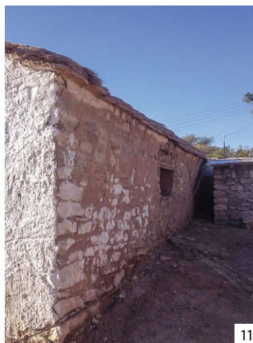
Figura 10 evidencia del empuje de los pares sobre el coronamiento del muro del Evangelio. Fuente S. Alfaro, junio 2014 / Figura 11 desplome en muro del Evangelio, encuentro con cuerpo perpendicular a la nave. Fuente S. Alfaro, marzo 2014
