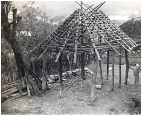
Figura 5 Armazón de cubierta sobre horcones, con bejuco y otate. Cuazahual, Tepehuacán de Guerrero, Hidalgo. Foto: Antonio Lorenzo Monterrubio (1991) / Figura 6 Planta arquitectónica de una casa actual en San Antonio, municipio de Molango, Hidalgo. Dibujo de Antonio Lorenzo Monterrubio (1991).
