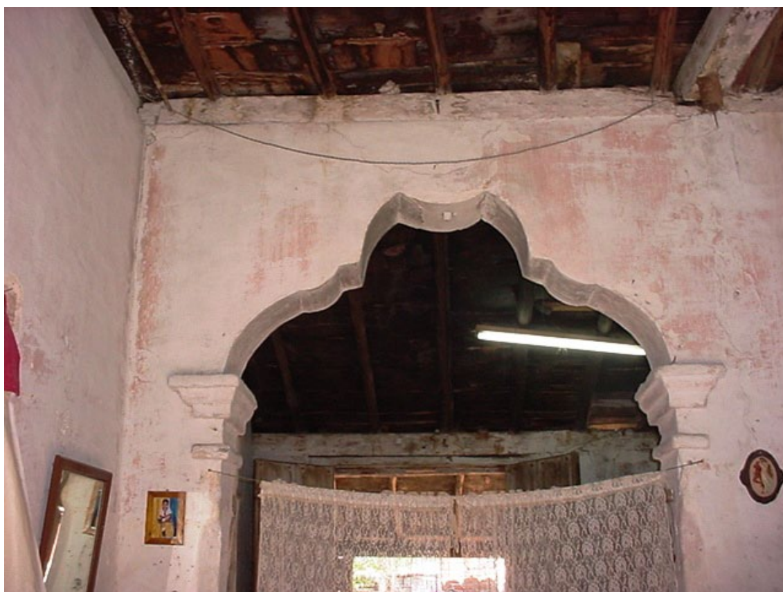
Figura 4 Empleo del arco mixtilíneo como elemento decorativo que jerarquiza el espacio interior de la vivienda, situada en Lugareño # 57. Su imperfección denota el status social de sus moradores y la ausencia de una mano de obra especializada. Fuente: Archivos del Centro de Estudios de Conservación y Desarrollo de las Construcciones (CECODEC).
