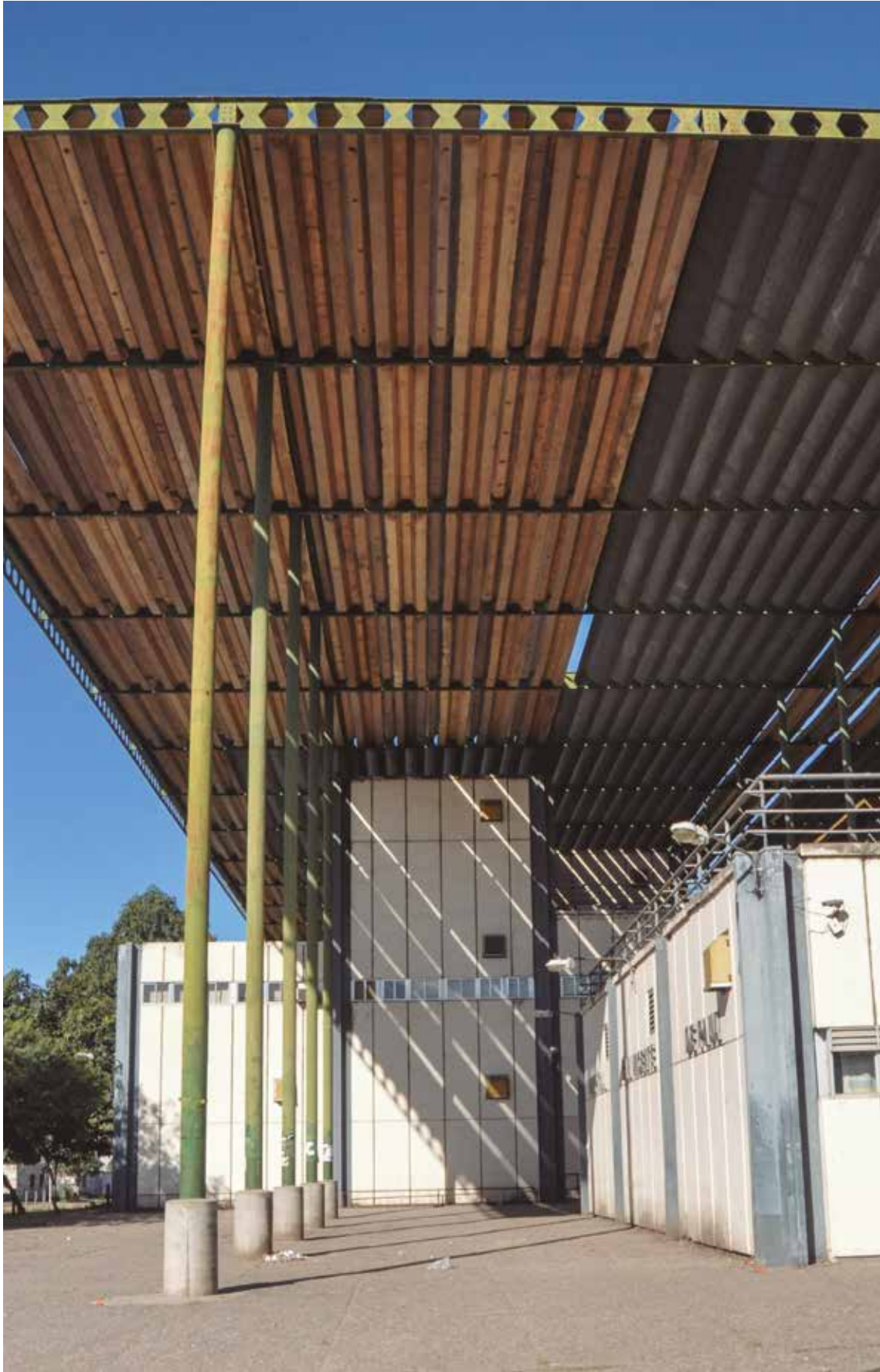
Figura 0 Llauro - Urgell. Hospital San Vicente de Paul. Fuente: Fotografía arquitecto Rubén Cabrera.
