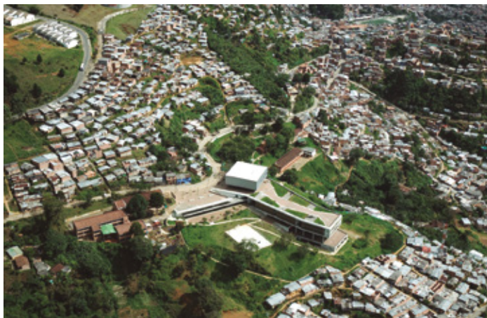
Figura 14 Colegio Santo Domingo – Medellín. Obra Negra Arqs. Fuente: Obra Negra Arqs. Luis Adriano Ramírez.
