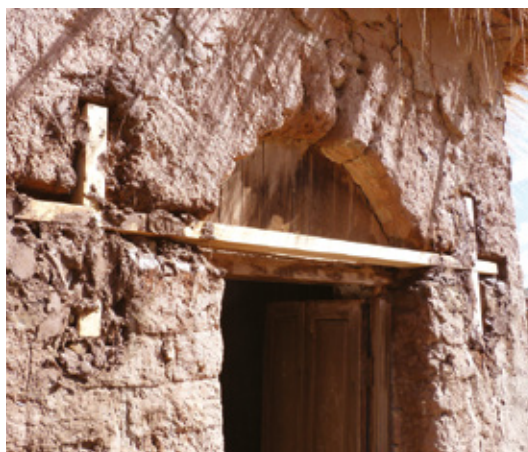
Figura 10 Colocación de llaves de madera en arcos. Fuente: Fotografía de las autoras.
