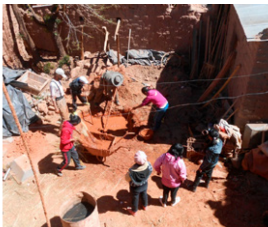
Figura 9 Realización del pozo de barro para la colocación de los manojos de paja con alumnos de la escuela primaria de Coranzulí. Fuente: Fotografía de las autoras.
