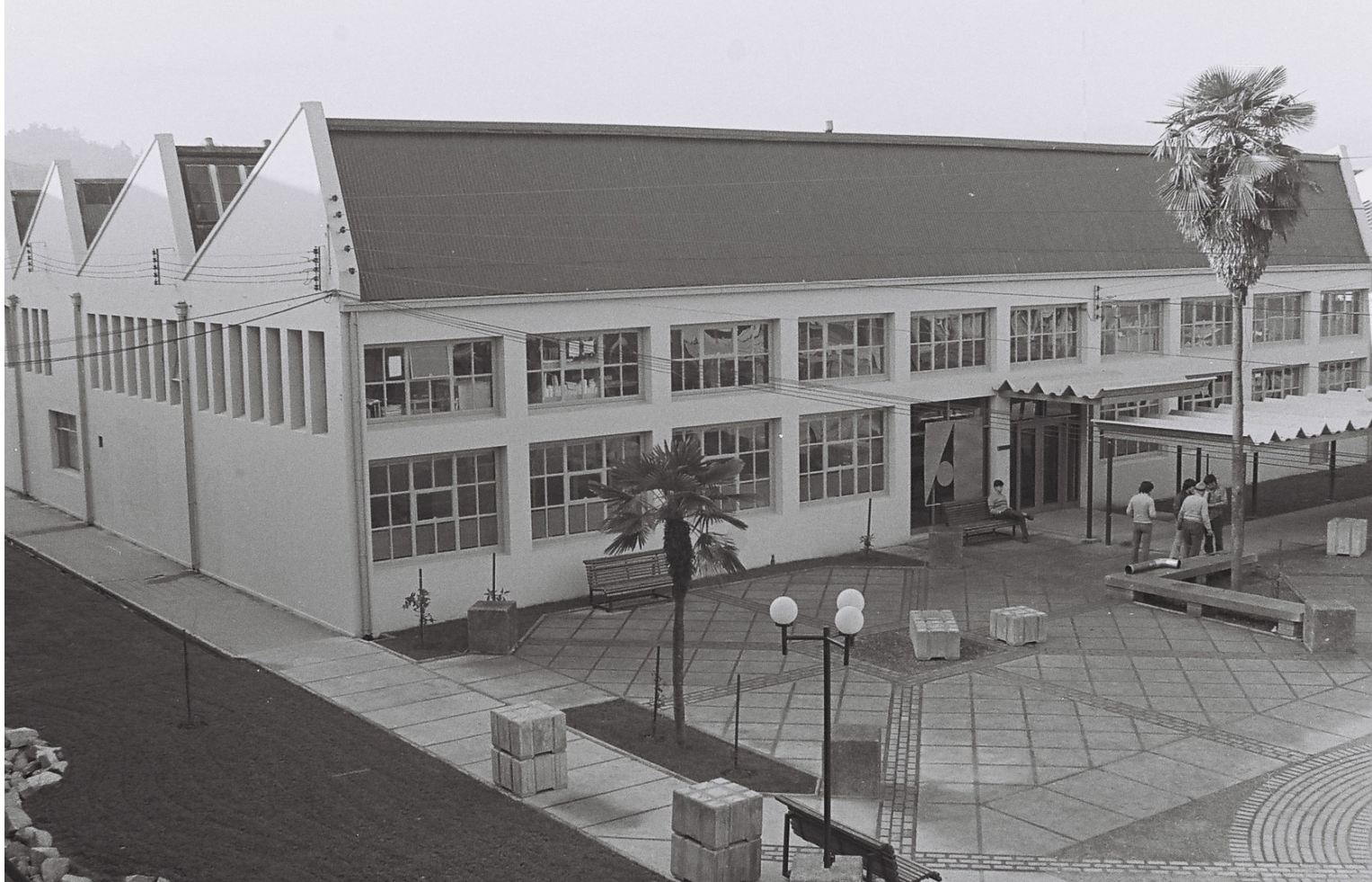
Figura 1. Edificio de la Escuela de Arquitectura, Universidad del Bío-Bío. Fuente: Archivo.
