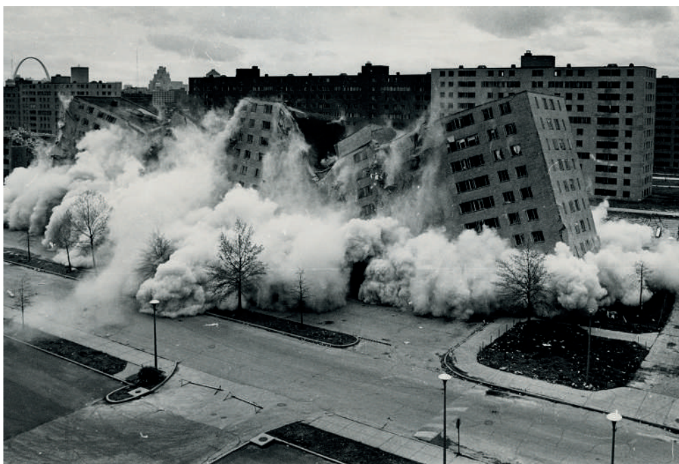
Figura 3 Demolición de Pruitt Igoe, Missouri, USA. Fuente: El Lenguaje de la Arquitectura Posmoderna (1983).
