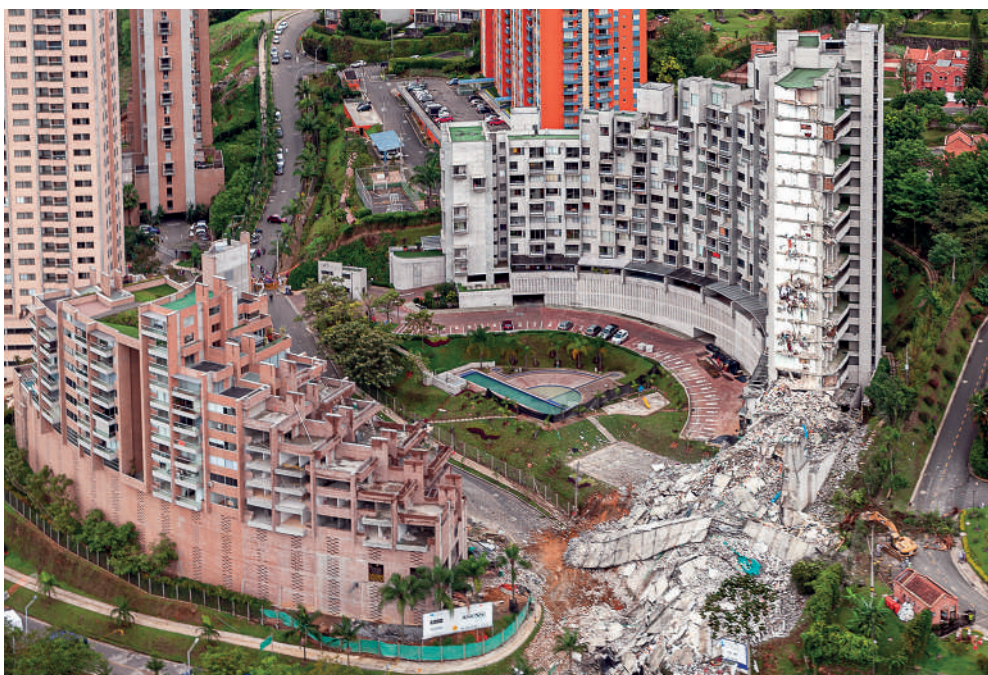
Figura 4 Edificio Space - Medellín. Fuente: Alejandro Castillo Bautista (2013)
