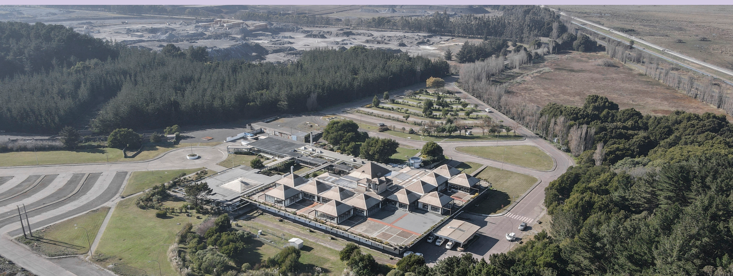
Figura 0 Vista aérea de la Central de Alimentación y Casino de trabajadores. 2021. Fuente: Colaboración del Arq. Nicolás Moraga.
