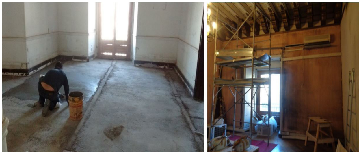
Figura 15 Trabajos conservación Ala Sur (2016 – 2018). Fuente: DARM MOP (2016).
