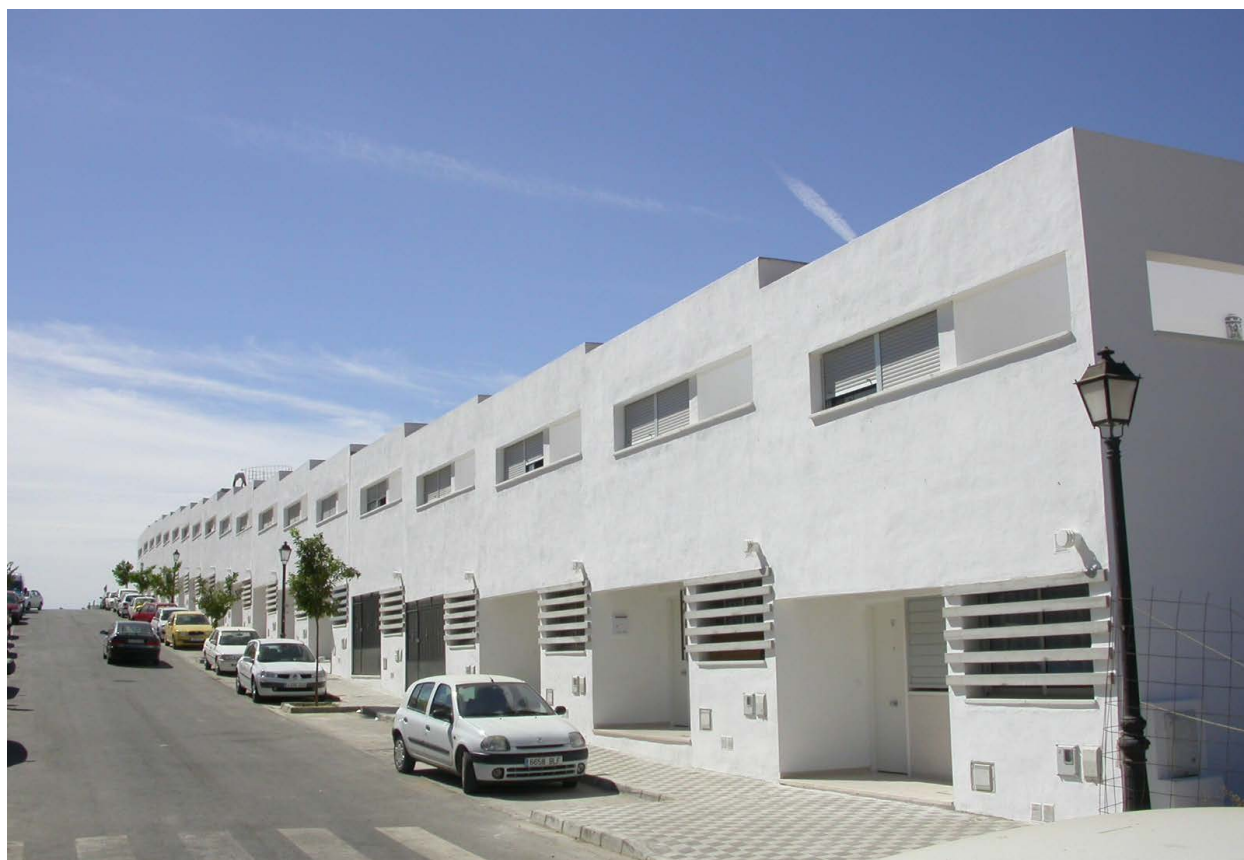
Figura 4. Viviendas de Autoconstrucción en Santiponce, Sevilla. Promoción situada junto al Conjunto Arqueológico de la ciudad romana de Itálica. Fuente: Fotografía del autor.
