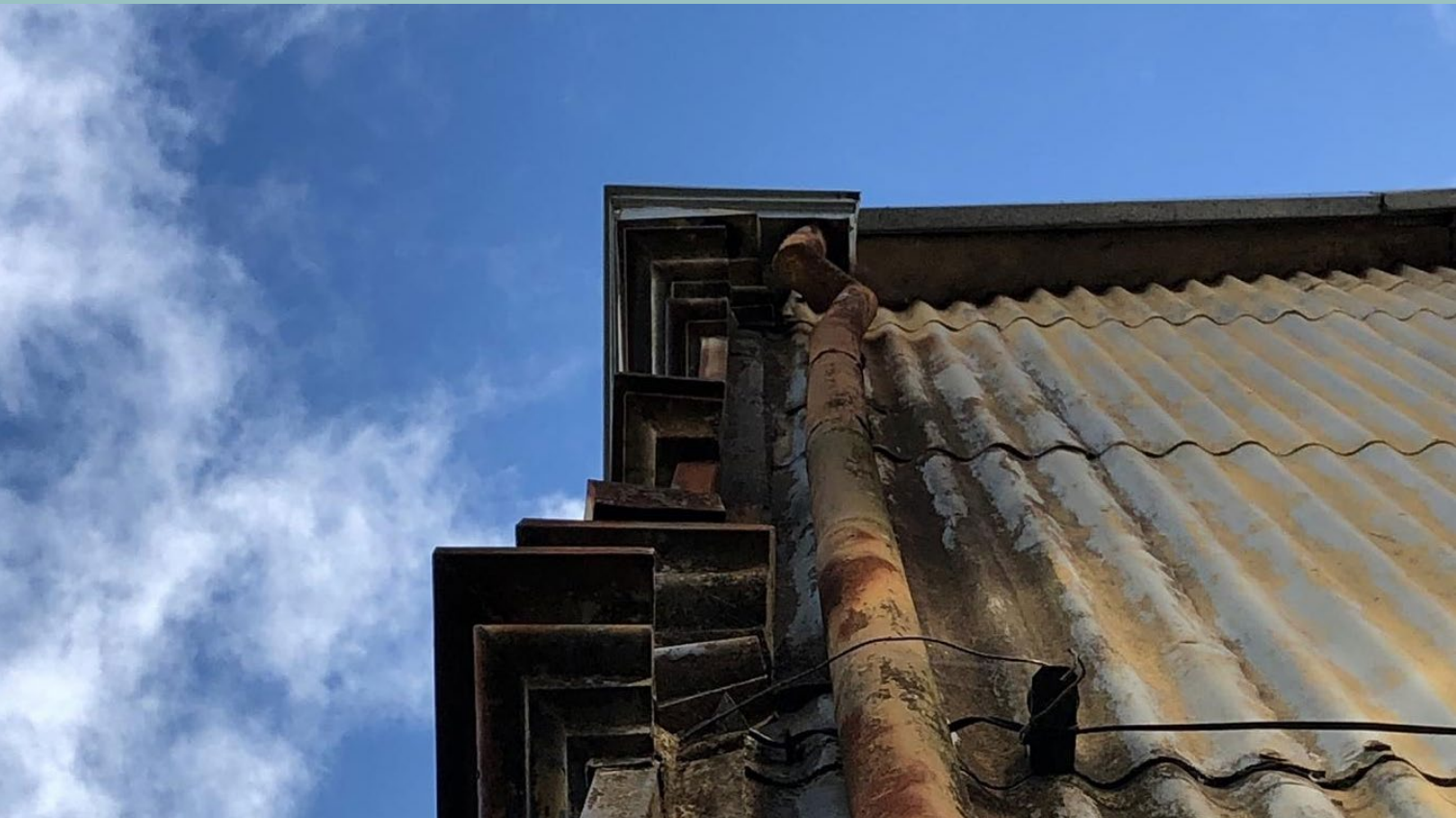
Figura 0. Inmueble con decorados emulando orden clásico en aristas y fachada lateral metal. Fuente: Elaboración del Autor.
