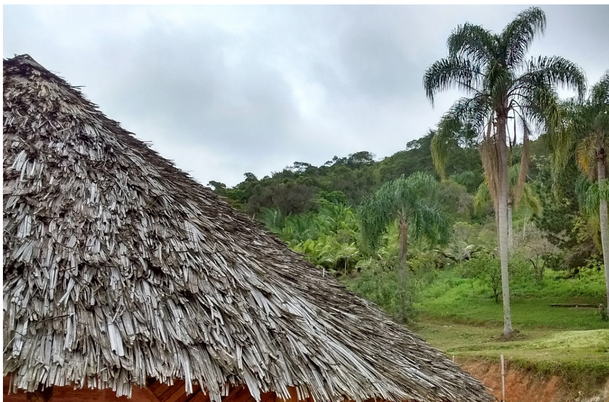
Figura 3. Opy coberta com taquara e conjunto de pindó no entorno, Tekoá Yynn Morotchi Wherá. Fonte: Zanin, 2021.
