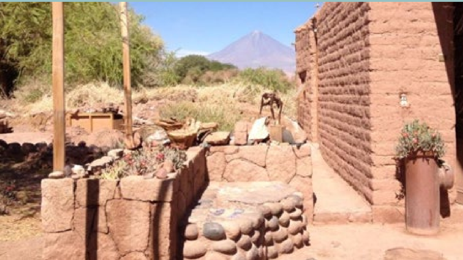
Figura 0. Fachada Norte Casa Taller. Fuente: Elaboración Propia del autor.
