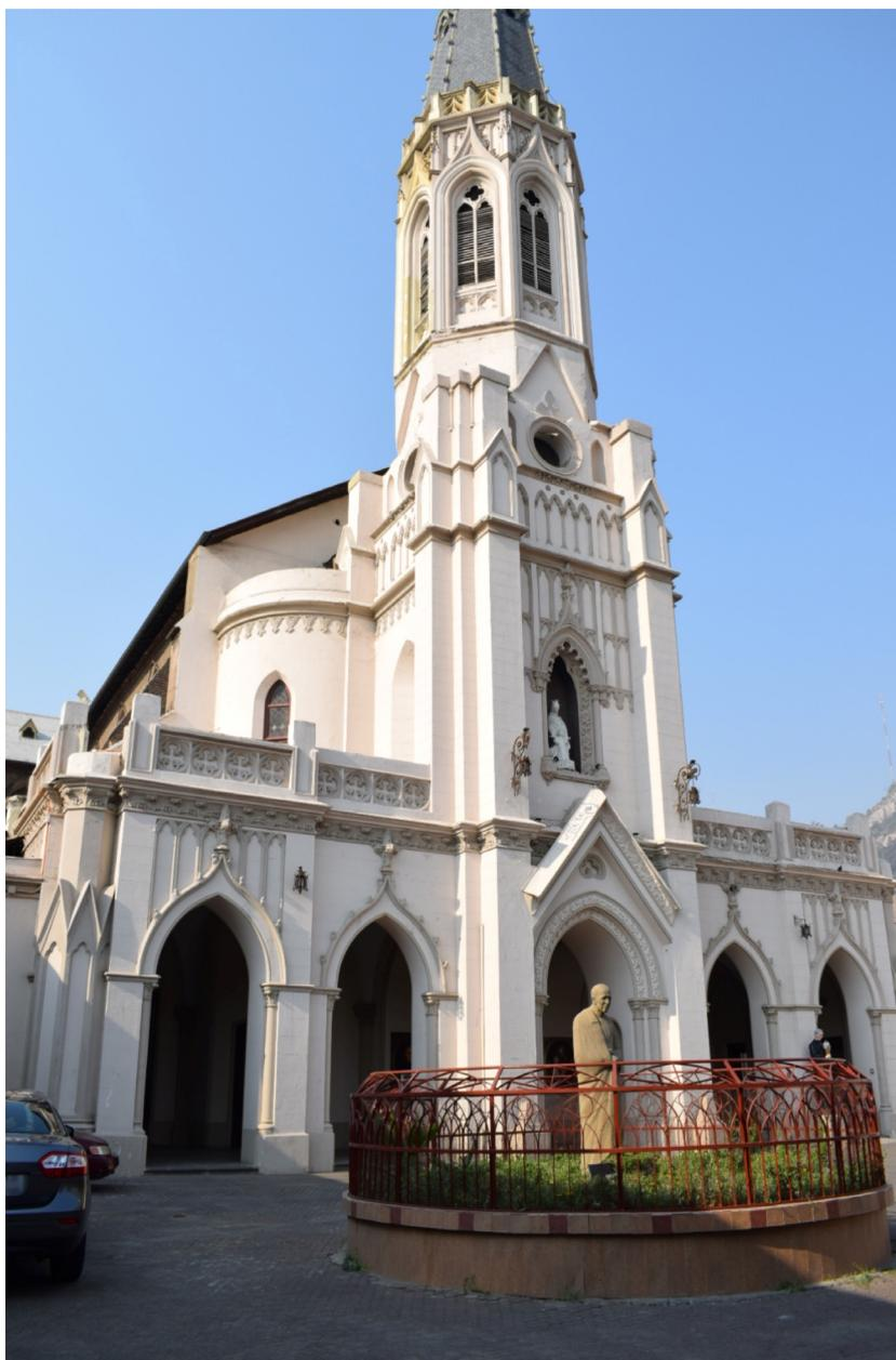
particularidades constructivas (Palazzi Chiara, 2019). Esta alta vulnerabilidad sísmica de los templos neogóticos está controlada por mecanismos de falla asociados a la esbeltez de los elementos estructurales y la falta de conectores entre muros que permiten un efectivo comportamiento de caja “box behavior” (Palazzi Chiara et al., 2020).
