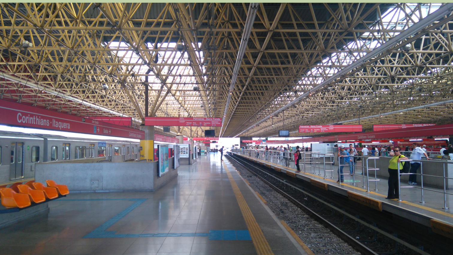
Figura 0. Vistas del andén y el techo del metro desde el interior de la estación. Fuente: Foto del autor en 2017.
