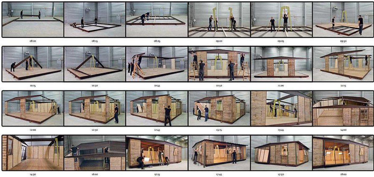
Figura 5. Sequência de montagem de uma casa desmontável 8x8, projeto de Prouvé, de 1944. Protótipo construído pela galeria Patrick Seguin, em 2013, na França. Fonte: Imagens de Galerie Patrick Seguin . Compilação de Peter Lobner (2025).
