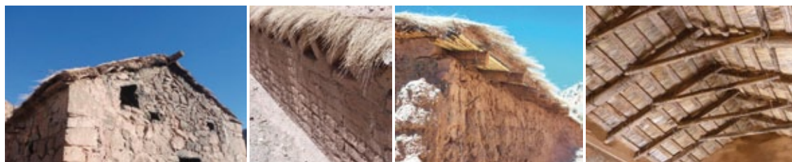
Figura 3 Técnicas constructivas en Coranzulí: muros de piedra y adobe, techados de guaya, estructuras de madera y cañas. Fotografías del autor.
