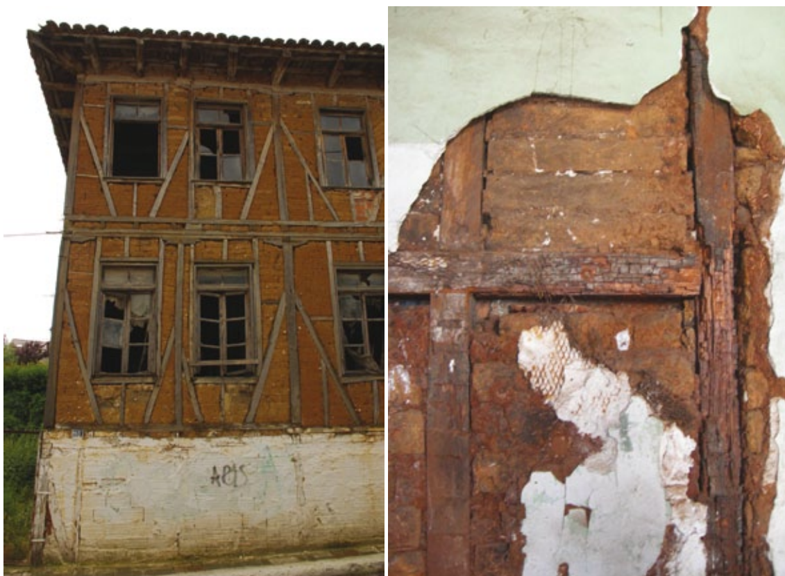
Figura 3 Contenciones de madera en edificaciones de adobe en Grecia y Chile. Fotos: Saverio Mecca y Natalia Jorquera, respectivamente.
