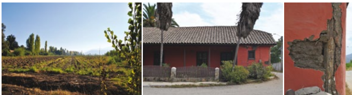
Figura 5 Relación entre territorio, recursos naturales y arquitectura vernácula del Valle Central, donde los muros con daños dejan entrever los elementos de madera incorporados como estrategia sismorresistente. Fotos: Natalia Jorquera.
