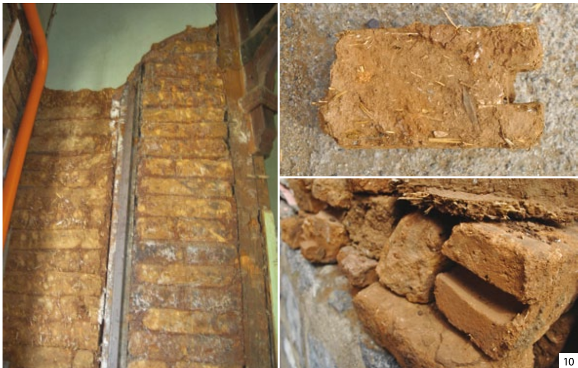
Figura 10 Detalle de la técnica tabique-adobillo de Valparaíso, donde la eficaz conexión entre ambos elementos da cuenta de la cultura sísmica. Fotos: Natalia Jorquera.
