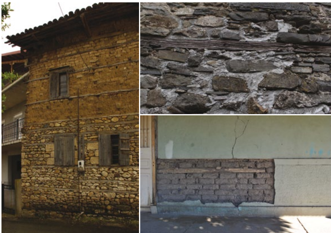
Figura 2 Llaves de madera presentes en mamposterías históricas de piedra y adobe en Grecia, Italia y Chile. Fotos: Saverio Mecca, Letizia Dipasquale y Natalia Jorquera, respectivamente.
