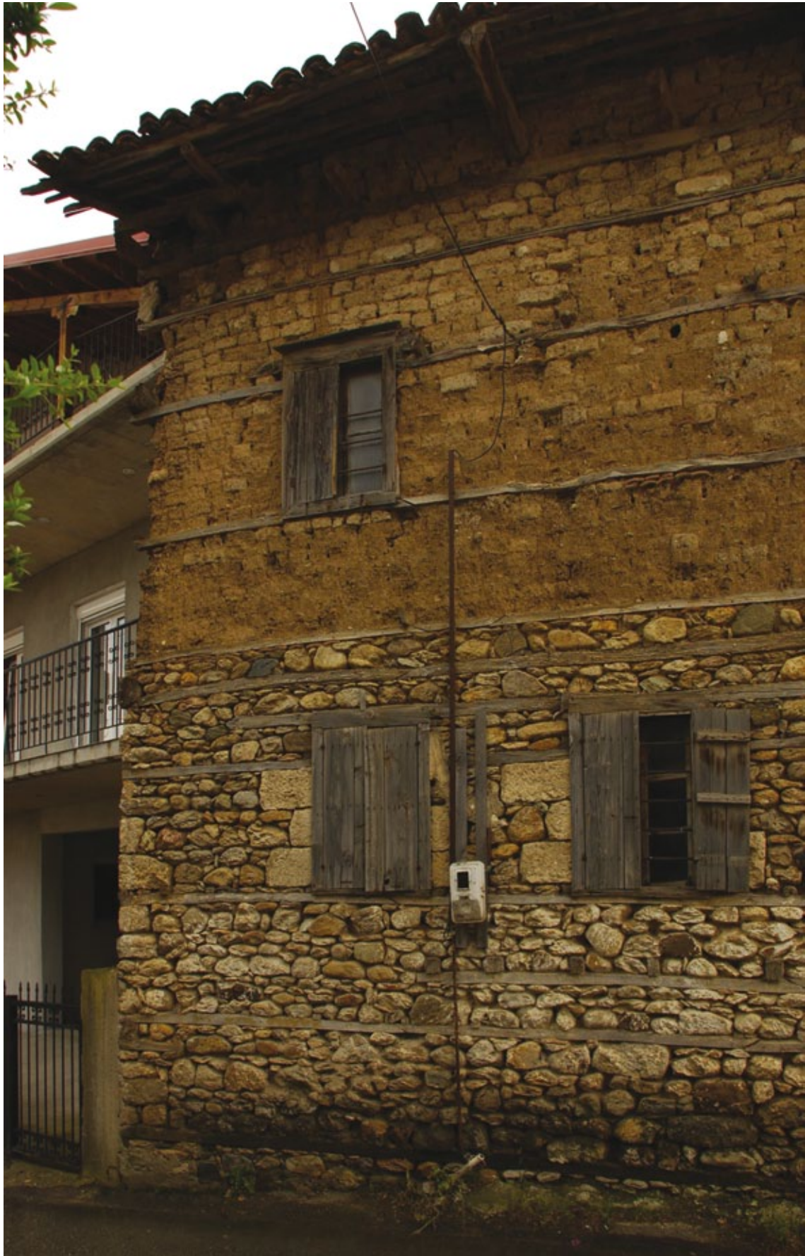
Figura 0 Liaves de madera presentes en mamposterías históricas de piedra y adobe en Grecia. Fotos: Saverio Mecca.
