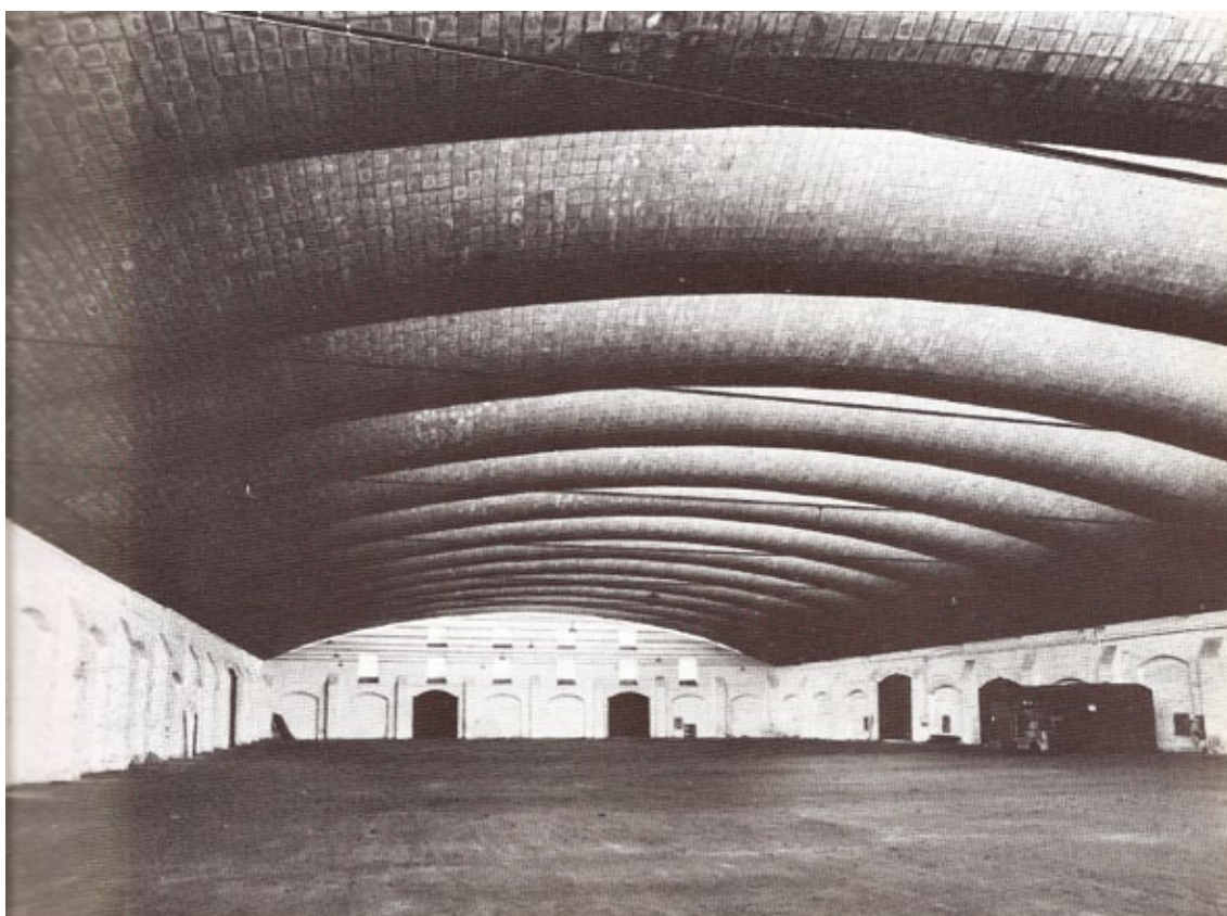
Figura 6 Vista interior del Depósito del puerto en Montevideo. Gasparini. Fuente: Carbonell, 1987:77.
