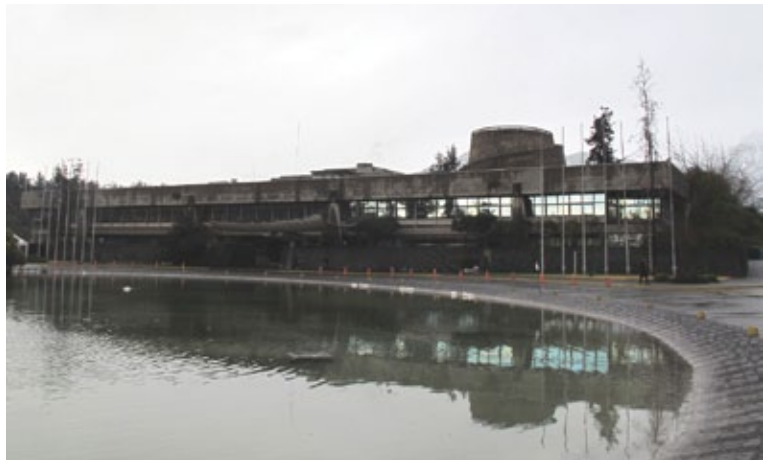
Figura 3 Edificio de la CEPAL, fachada principal (Sur). Estado actual. Fuente: Fotografía del autor.
