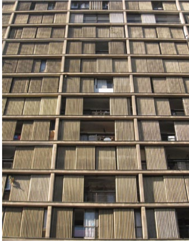
Figura 6 E. Duhart. Edificio de viviendas de la Calle Catedral, Santiago de Chile (1956). Fuente: Fotografía del autor.
