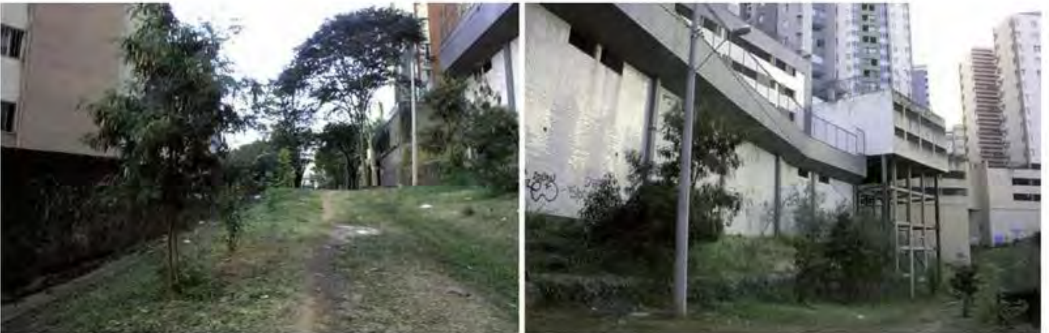
Figura 8 Trecho no pavimentado de la calle Nicaragua, Fuente: archivo personal de la autora
