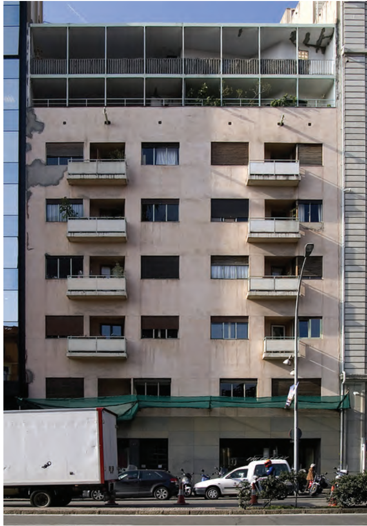
Figura 5 Germán Rodríguez Arias, estado actual del edificio de viviendas para su familia en el nº 41 de la Vía Augusta, Barcelona, 1931.
