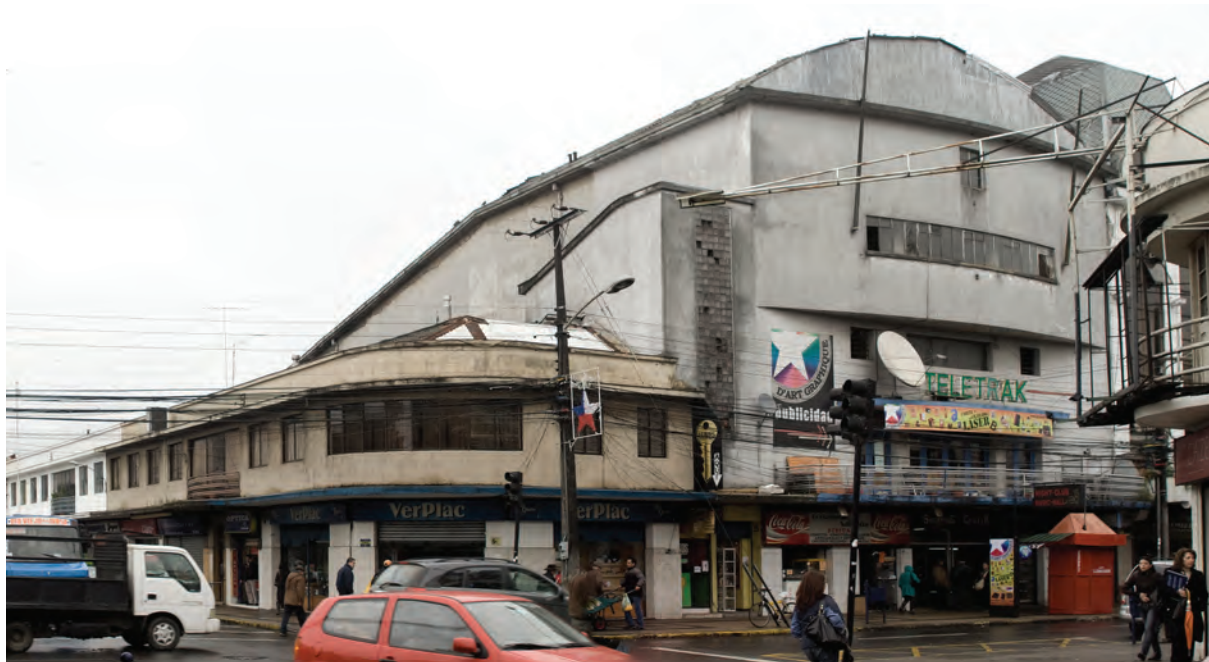
Figura 2 Estado actual del edificio. Calle Constitución esquina 5 de abril, Chillán. Foto: Hernán Ascui.
