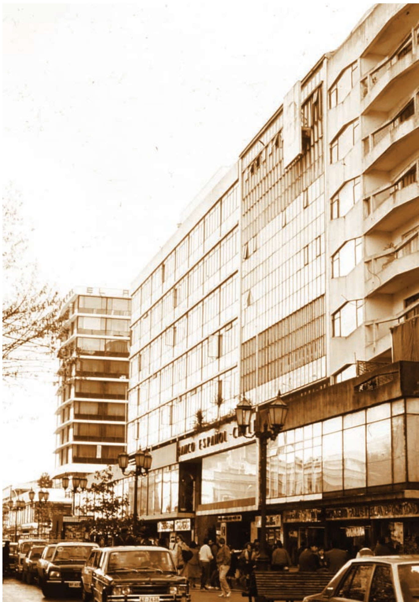
Figura 0 Parámetros en los que actuó el plan regulador. Esquina Calle Barros Arana y Calle Caupolicán, se enfrentan el Hotel Araucano del arquitecto Julio Ramos y el Edificio Fiuc de los arquitectos Alejandro Rodríguez, Osvaldo Cáceres, G. González y Gutiérrez. Foto: Roberto Goycoolea I.
