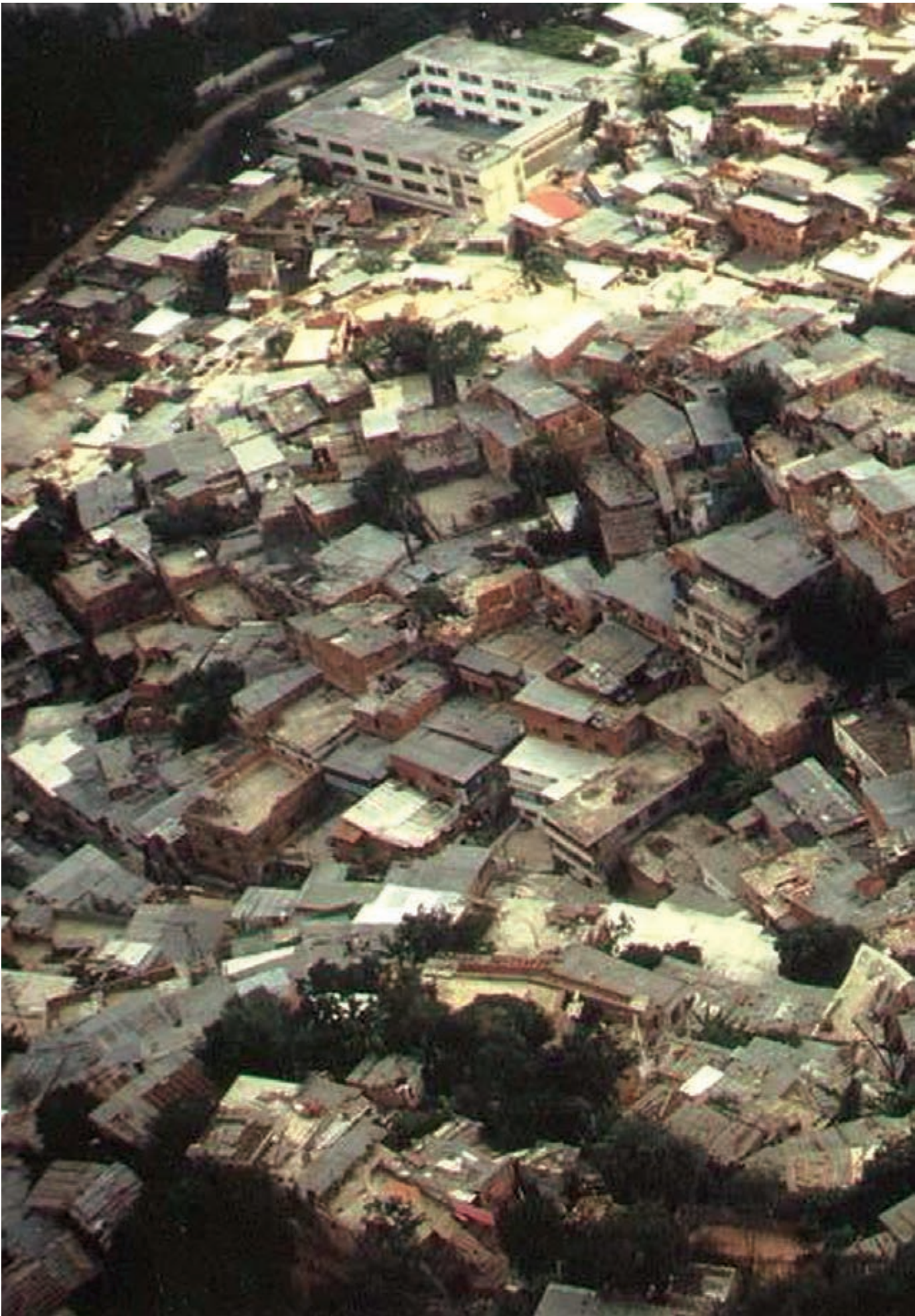
Figura 4 Ejemplo de nivel de riesgo urbano construido en nuestras ciudades. Foto: J. Molina
