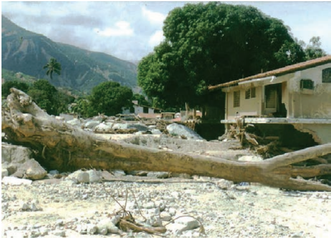
Figura 6 Daños asociados a eventos de hidrogeológicos registrados en la costa norte de Venezuela en diciembre de 1999. Foto: Alejandro Linayo.
