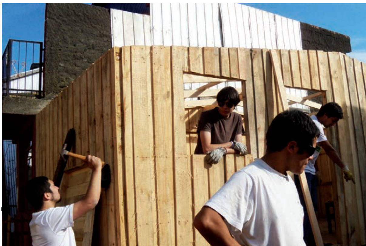
Figura 1 Construcción de media-aguas en Lirquén. Foto: Juan Carlos Briede W.
