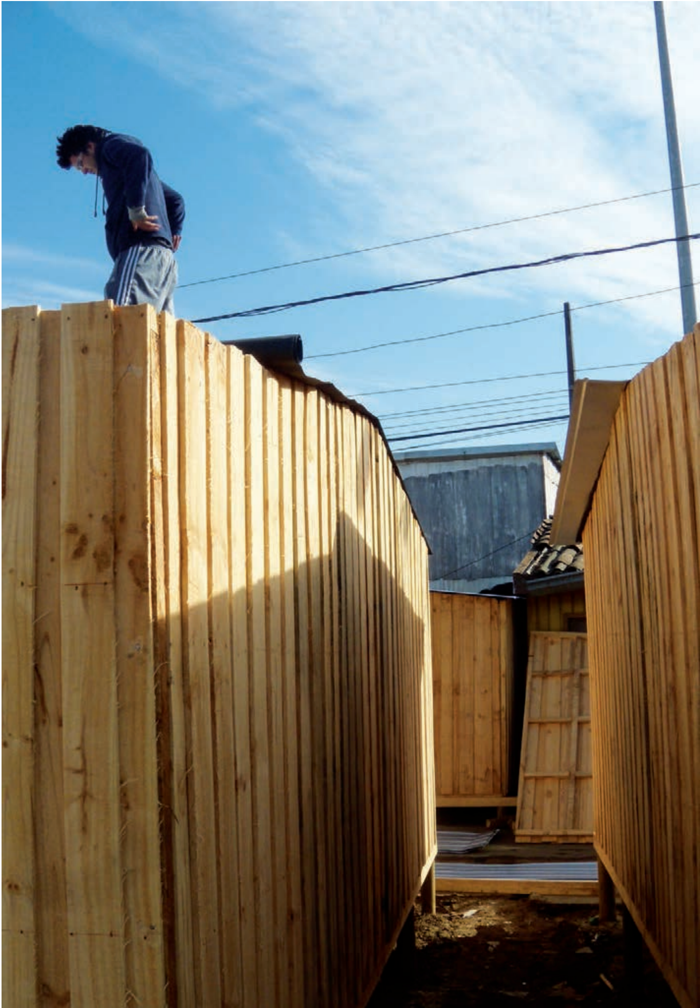
Figura 0 Construcción de media-aguas en Lirquén. Foto: Juan Carlos Briede W.
