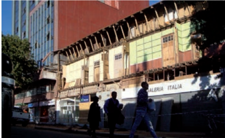
Figura 2 Portal Ex- Casa Loosii demolido, Abril 2010. Foto: Viviana Vilches Wolf.
