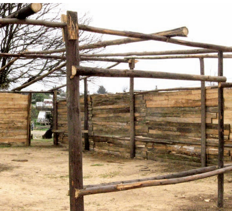
Figura 7 y 8 Los materiales utilizados son fundamentalmente varas de eucalipto que dan forma a la estructura soportante. Como revestimiento para las paredes, pisos, techos y muebles se usan tapas y charlatas de madera, planchas de zinc, lonas de plástico, aserrín y ramas de retamillo que cubren finalmente toda la construcción. Las varas de Eucalipto son cortadas en los bosques del sector, y son guardadas durante el año en casas aledañas de amigos y familiares de los fonderos para su reutilización. La retamilla es recolectada cada año desde la ribera del río Rafael por quienes llegan a colaborar a cambio de vino y comida, y es el único material que no se reutiliza quemándose al centro de la cancha al terminar la fiesta.
