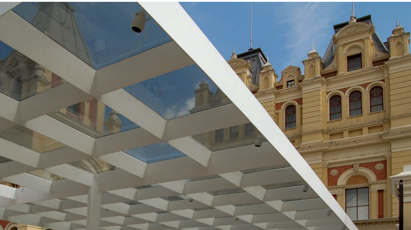
Figura 4 Museo de la Lengua Portuguesa (2006): revitalización, actualización y restauro del edificio administrativo de la Estación Luz, São Paulo/ Brasil - arquitectos Paulo y Pedro Mendes da Rocha: foto Haroldo Gallo. – Esa intervención provocó polémicas y contraposiciones entre conservación e innovación antes de su realización. Hubo una criteriosa intervención de restauración en los lugares donde el edificio se mantenía íntegro y original, y una mayor flexibilidad de transformación donde la edificación ya había sufrido transformaciones. El punto de partida arquitectónico y el nuevo uso agregaron nuevos valores y extendiendo la fruición de ese edificio específico de los ferrocarriles a un público amplio.
