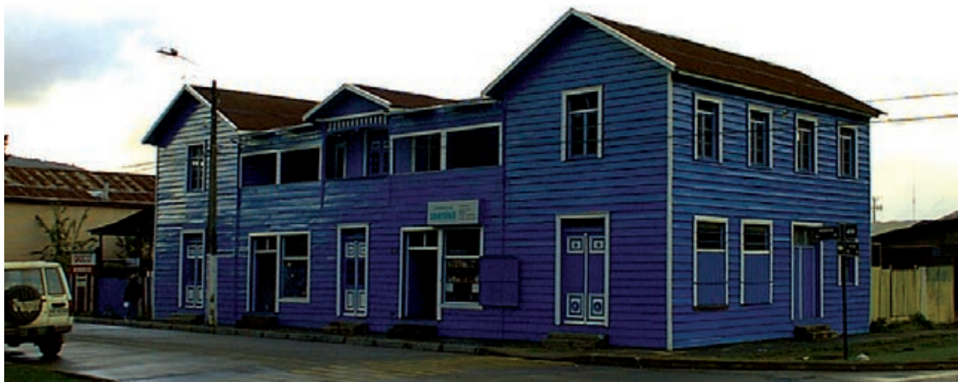
Figura 4 y 5 Progreso de obras de restauración Casa Carrasco. Foto: Roberto Burdiles.
