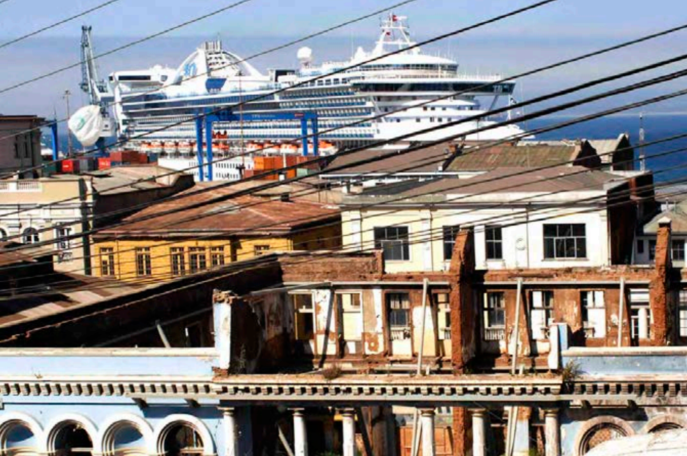
Figura 2 Edificio Subercaseaux (año construcción 1881- 1888) ubicado en Serrano 353-389, Valparaíso. Incendiado por completo quedando solo sus muros perimetrales en pie y parcialmente los interiores.
