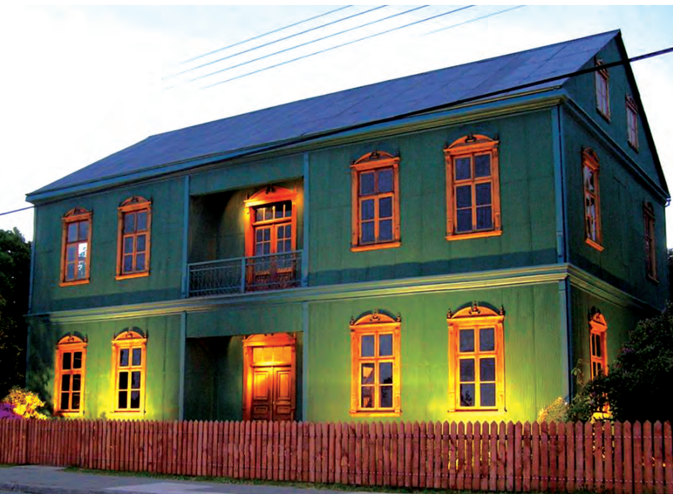
Figura 5 Casa Richter reparada, restaurada y reciclada. Foto: Christian Valenzuela.
