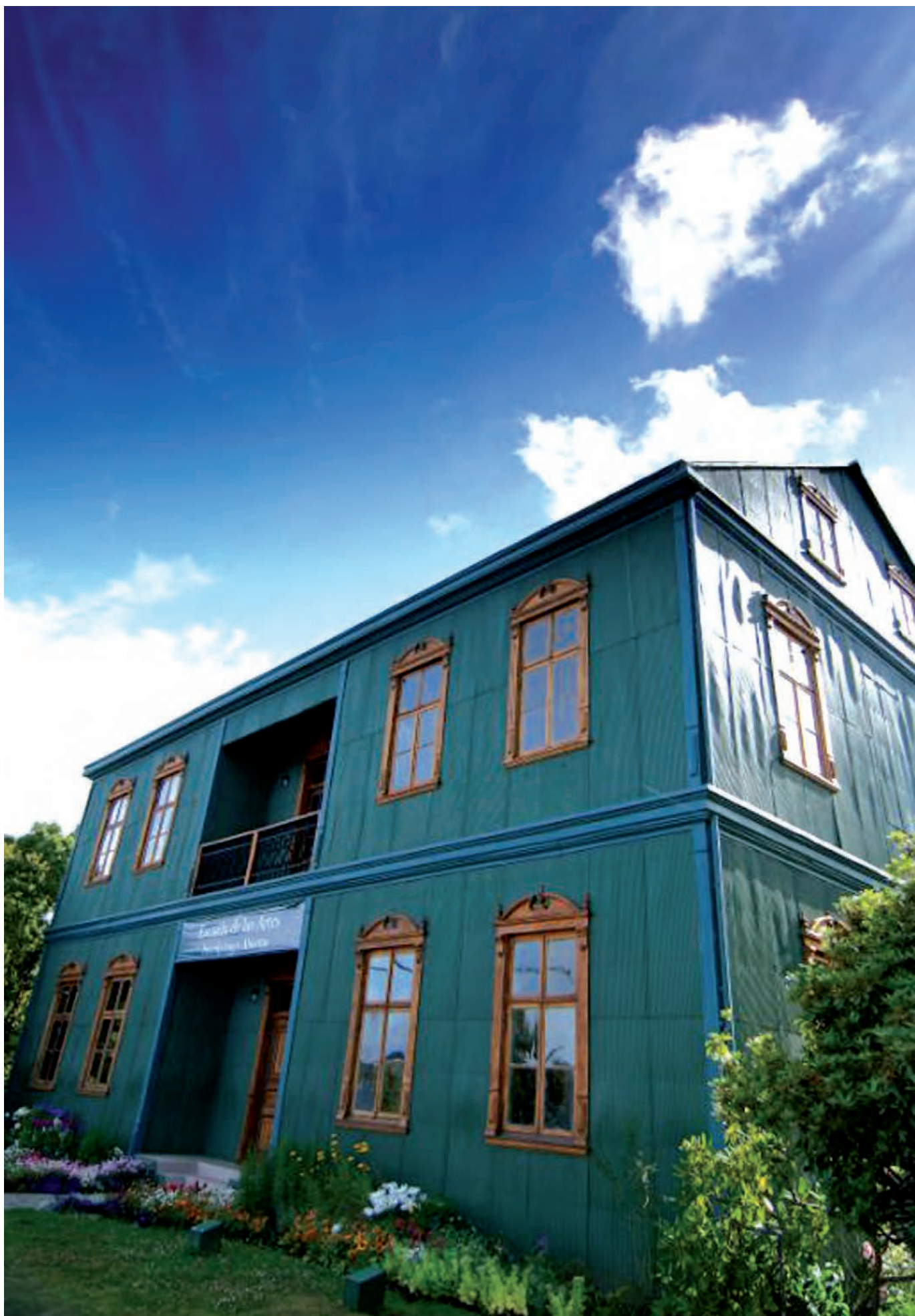
Figura 0 Fachada casa Richter reparada. Foto: Christian Valenzuela.
