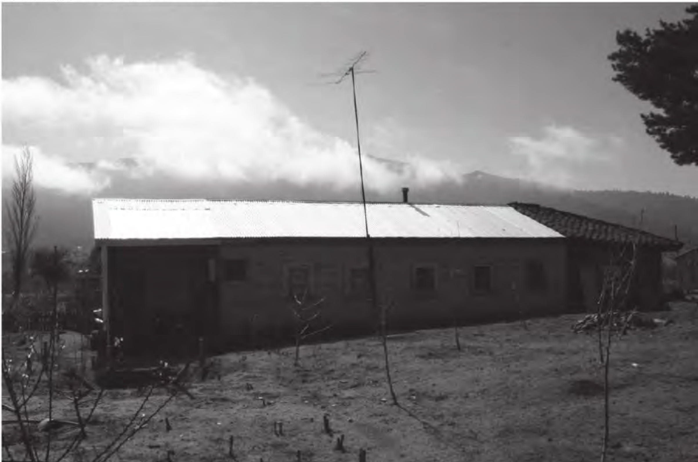
Fig. 4 Vista posterior de la vivienda / Rear view of the house
