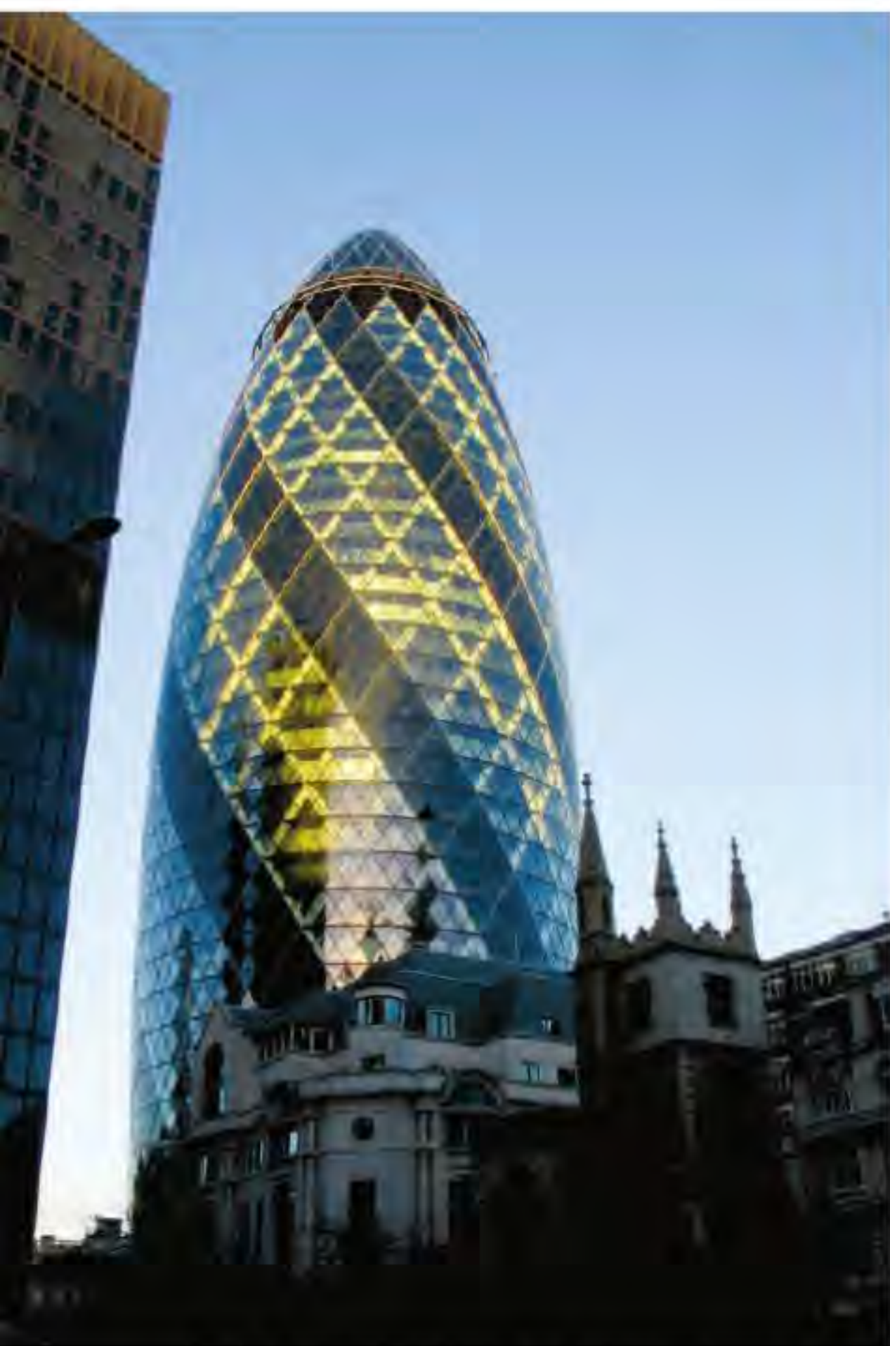
Fig. 3 edificio 30 St Mary Axe (Swiss Re), Londres, Inglaterra. Arqts. Foster and Partners / foto: Maureen Trebilcock
