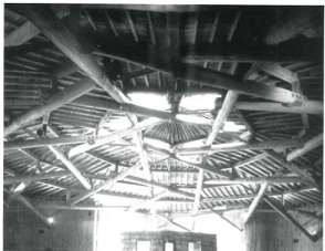
Mercado de Dalcahue, Chiloe. Estructura de torre en marco recíproco.
