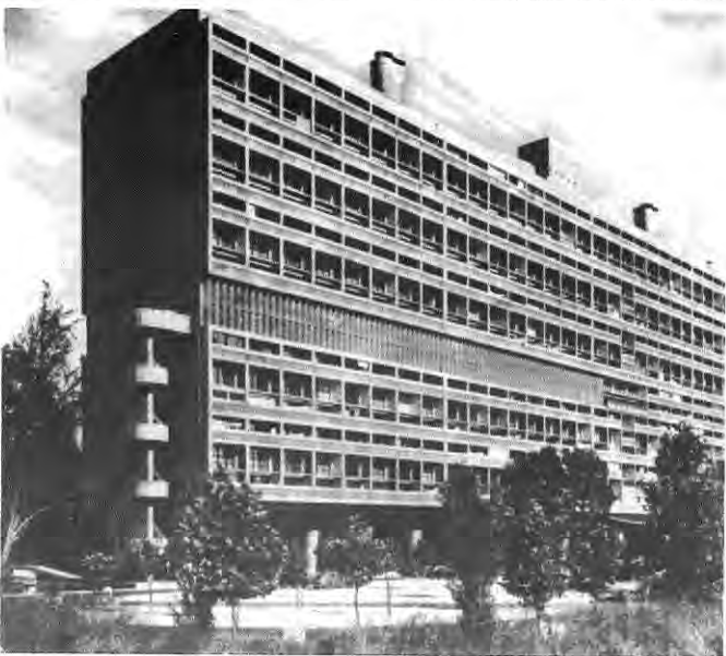
Unidad habitacional de Marsella. Le Corbusier.
