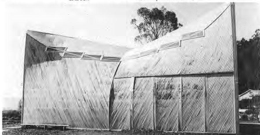
Capilla construida por la U.C.V. 1960
